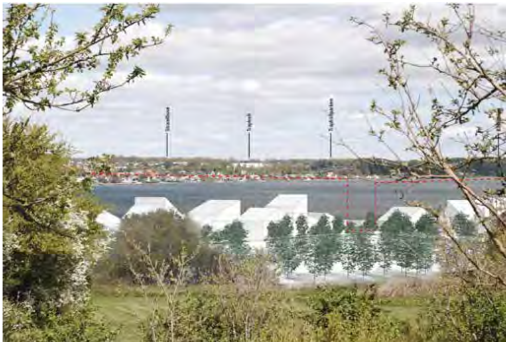
Figur 1-14: Marina City visualiseret fra Fælleshusets terrasse i Fjordparken. Fotostandpunkt 6 i Figur 1-9.
